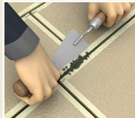
fugowanie uszczelniaczem zabezpieczonych płyt
